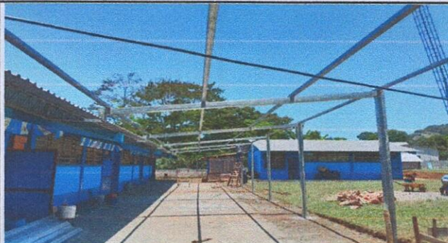
Foto 6: Imagen de la estrura del corredor que se cambió.
