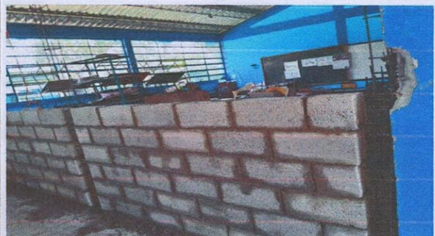
Foto 4: Imagen de la división de se cambió por nueva pared.
