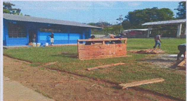
Foto 2: Imagen de la nueva pintura en proceso.
